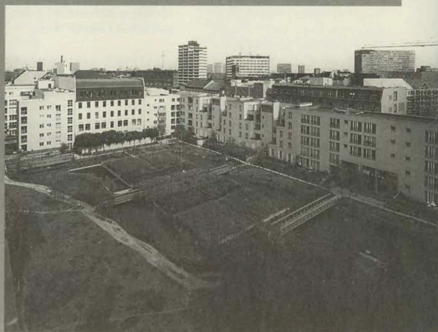
Pflanzenkläranlage Block 6, Berlin
