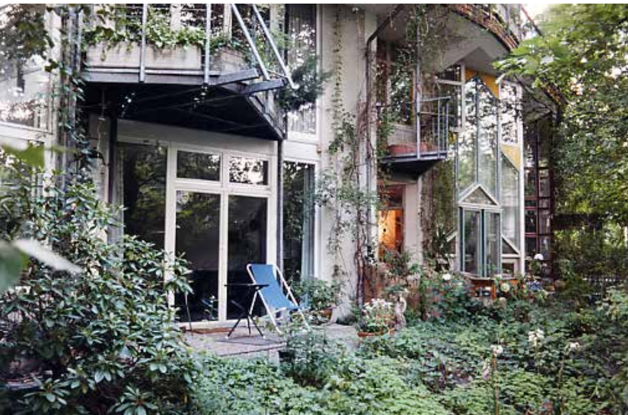
Abb. 4: Blick auf das Südwest-Haus von der Comeliusstraße aus
