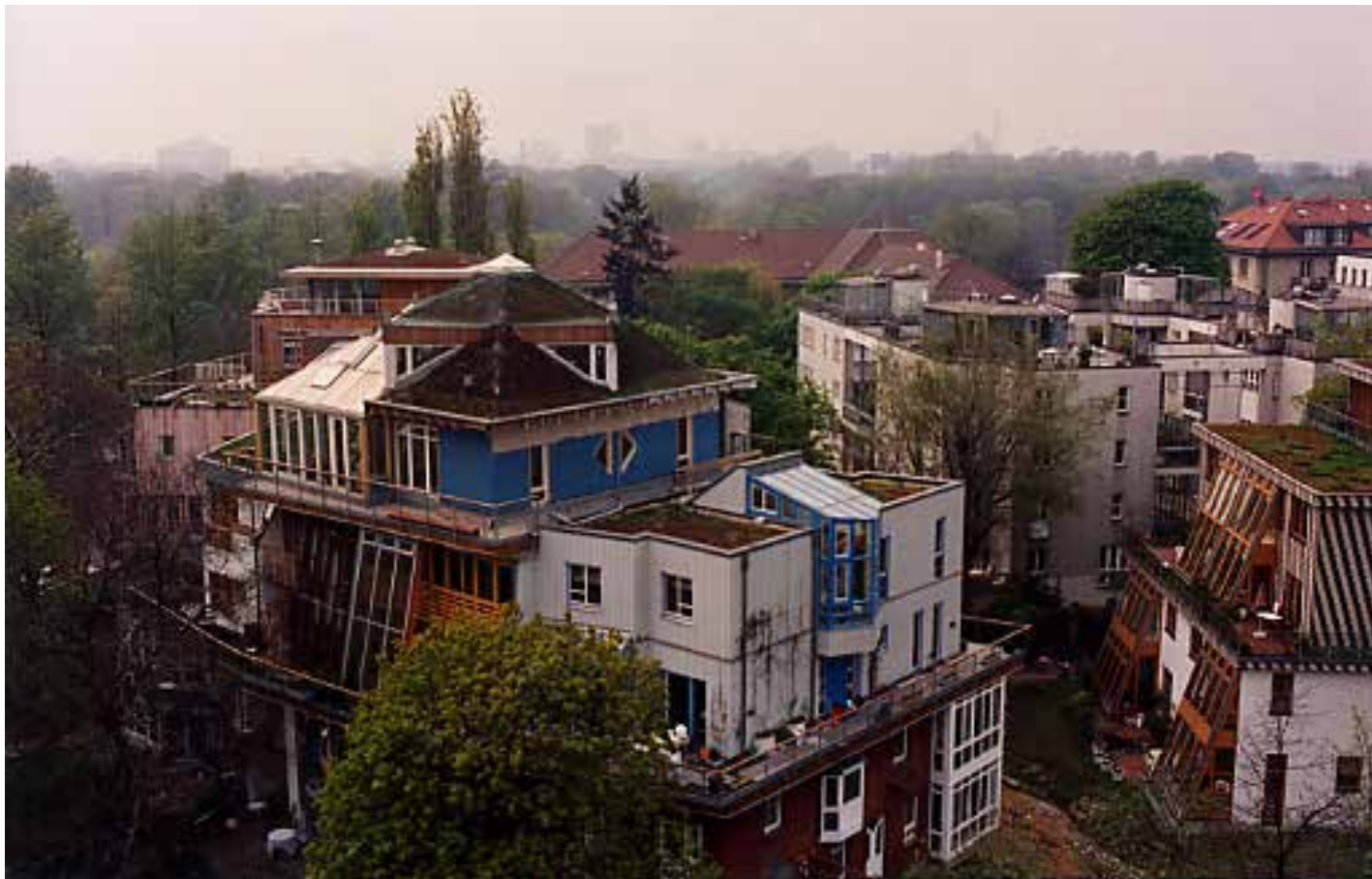
Abb. 5: Blick auf die Süd-Häuser (rechts Nord- Haus angeschnitten) 1991
